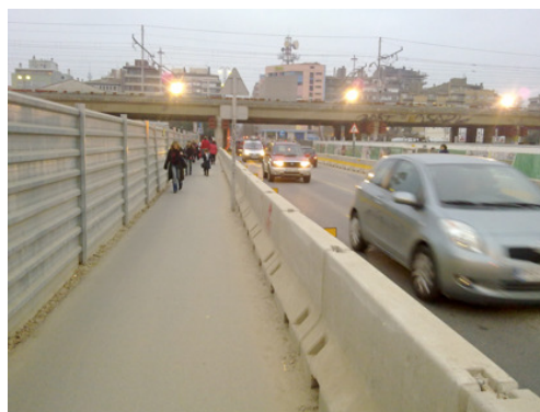
Afectació als vianants
