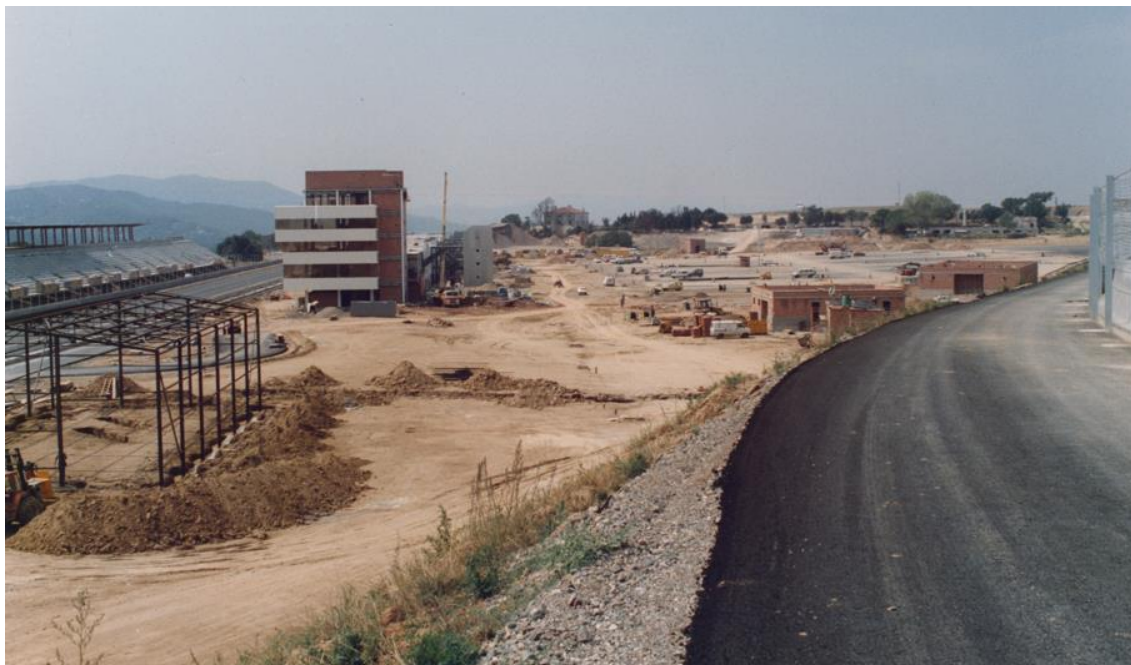
1991 Obres. Procés d'asfaltat. A l'esquerra de la imatge, a banda i banda de la recta principal, la tribuna i la torre de control van prenent forma.
