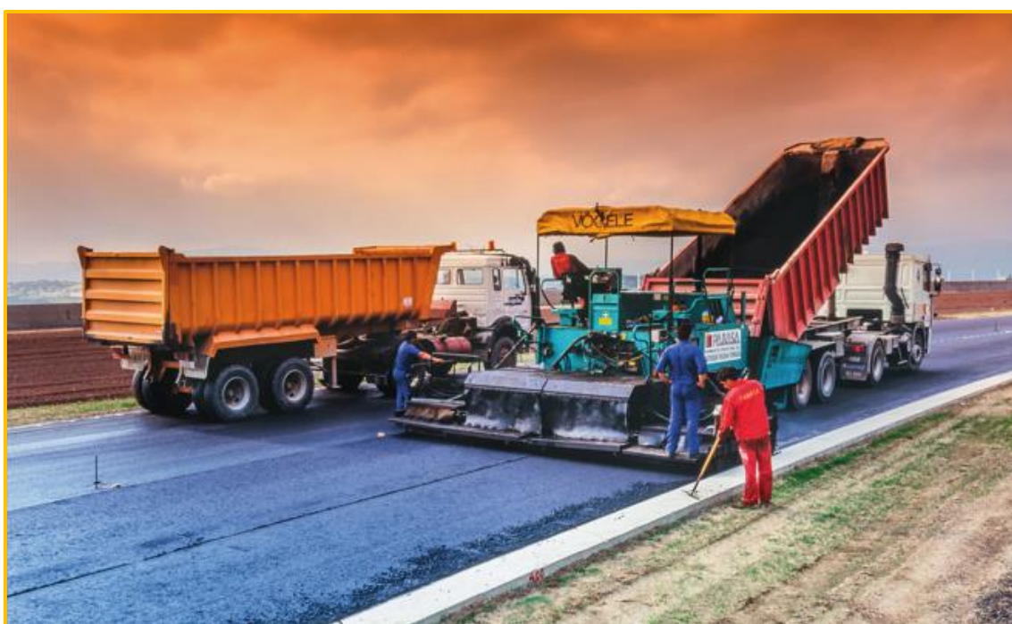
1990 Obres d'asfaltat de la pista. Les obres de construcció del Circuit van durar menys de tres anys i van anar a un ritme frenètic.
